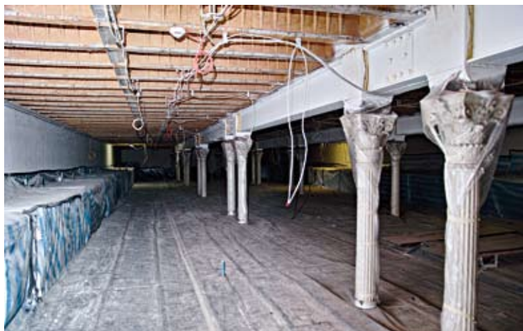
Abbildung 16. Über den abgehangenen Decken ist deutlich zu sehen, dass beim Wiederaufbau nach dem Zweiten Weltkrieg oft sehr pragmatisch vorgegangen werden musste. Die Schönheit des Berckmüllerbaues von 1865 hat durch Krieg und Mangel der Nachkriegszeit zweifellos gelitten.
