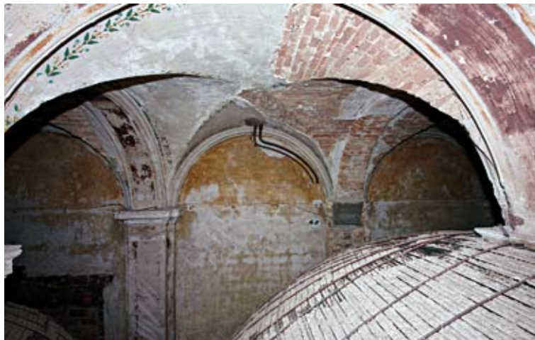
Abbildung 15. Die verschlossenen Gewölbe über den Dioramen in der Parterre im Mittelteil des Hauses waren im Zuge der Brandschutzmaßnahmen erstmalig seit dem Wiederaufbau in den 1950er Jahren wieder sichtbar. Es wird diskutiert, ob man sie den Blicken der Besucher zugänglich machen sollte.
