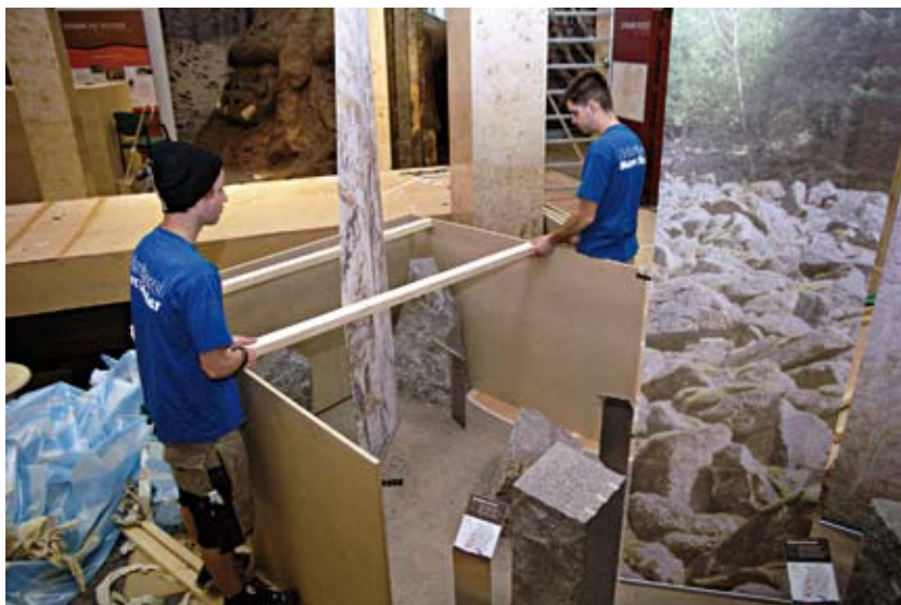
Abbildung 10. Um Bau-freiheit für die Brand-schutzmaßnahmen zu schaffen und die Aus-stellung zu schützen mussten alle Objekte, die nicht ausgelagert werden konnten, auf-wändig eingehaust werden. Im Bild Arbeiten im erst vor wenigen Jahren neu gestalteten Saal „Geologie am Ober-rhein“.
