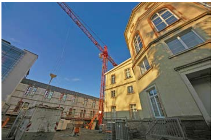
Abbildung 22. Den mineralischen Bauschutt nehmen transportable Schuttmulden auf, damit er einer fachgerechten Wiederverwertung zugeführt werden kann.
