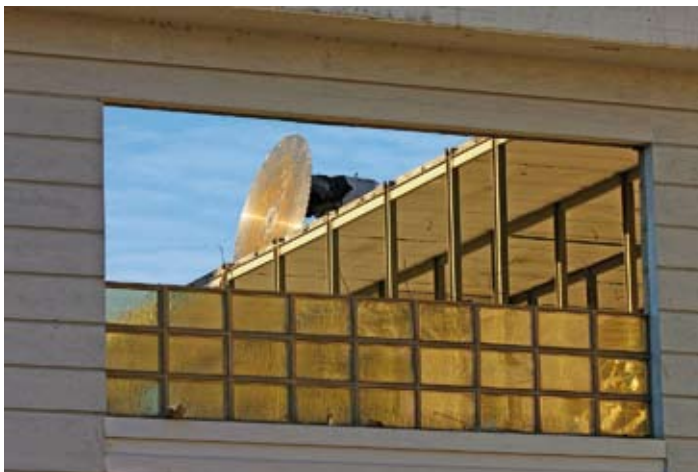
Abbildung 19. Mit überdimensionalen Trennscheiben wird der Stahlbeton des Nachkriegsbaus für den Abtransport fein säuberlich zerlegt.
