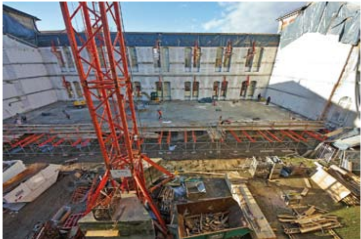
Abbildung 21. Zügig schreitet der Rückbau voran. Nach nur drei Monaten konnte bereits mit dem Aufbau begonnen werden.
