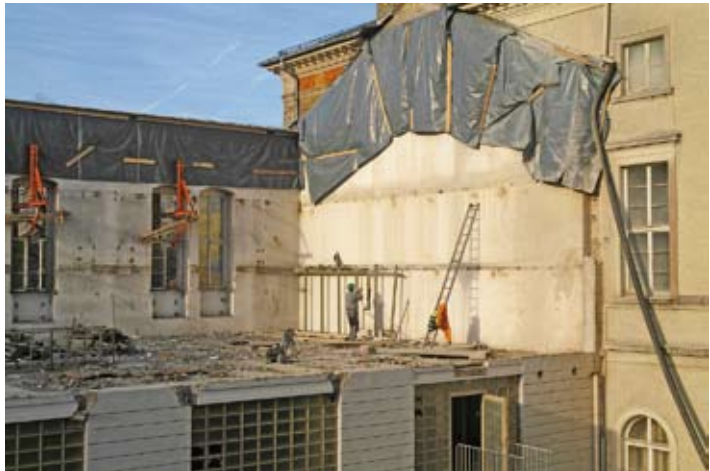
Abbildung 20. Dachgeschoss und obere Stockwerke sind schon weg! Freie Mauerbereiche, insbesondere zu angrenzenden Gebäudeteilen, werden vor Regen mit Folie geschützt, damit die Feuchtigkeit, ein großer Feind eines Museums, keinen Schaden anrichten kann.
