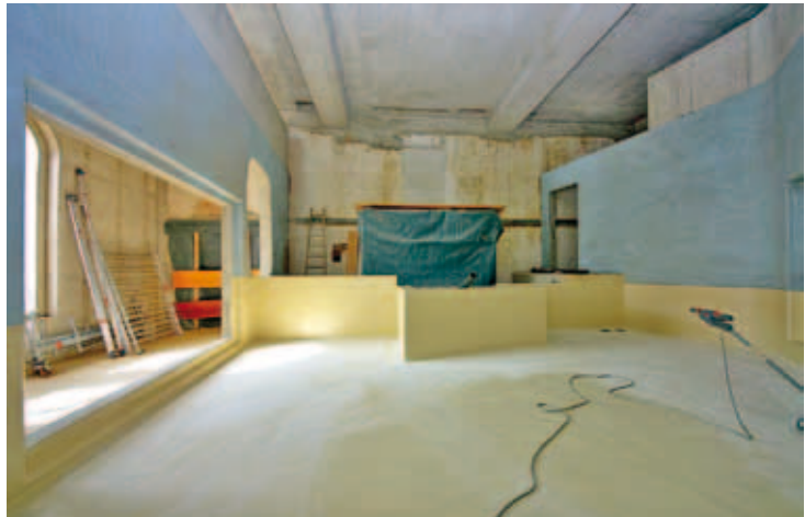
Abbildung 56. Aller Anfang ist schwer: Bevor die Australischen Süßwasserkrokodile die neue Krokodilanlage beziehen können, sind noch viele Maßnahmen notwendig, wie beispielsweise die Beschichtung des Betons mit Kunstharz (Juni 2014).
