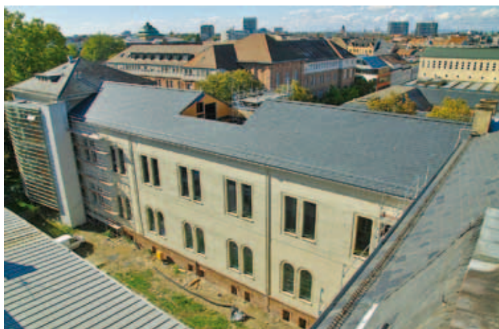
Abbildung 54. Im Oktober 2014 ist der Westflügel fast fertiggestellt. Im Dachgeschoss entsteht die neue Lüftungszentrale, die später mit einem Lamellendach verschlossen werden wird.
