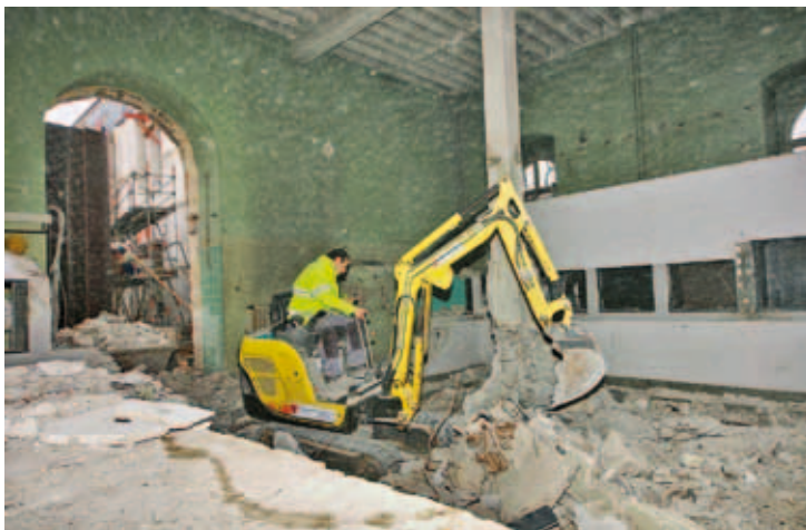
Abbildung 46. Das Vivarium der vergangenen Jahrzehnte wurde vollständig abgerissen, die neue Ausstellung ist hier noch nicht zu erahnen.
