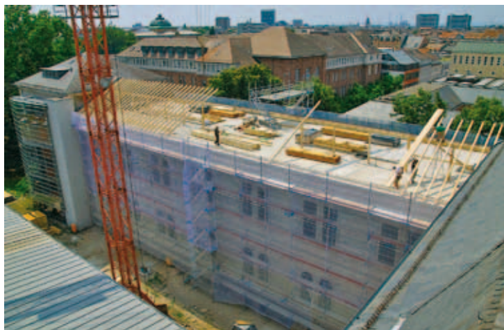
Abbildung 53. Nach Fertigstellung des Obergeschosses, in dem ein neuer Sonderausstellungsraum entsteht, wird im Juni 2014 der Dachstuhl errichtet.
