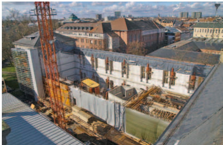
Abbildung 52. Beim Abriss des Westflügels blieb die historische Fassade entlang der Ritterstraße bestehen. Im Februar 2014 nehmen die zellförmigen Großbecken aus Beton im Erdgeschoss Gestalt an – sie werden später die Betondecke zum Obergeschoss stützen.
