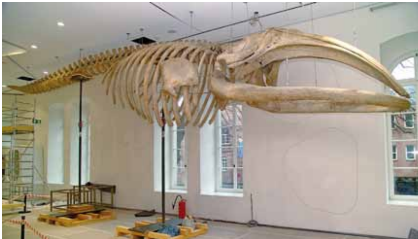
Abbildung 73. Die Montage des Walskelettes musste kurz vor der Fertigstellung unterbrochen werden, da sich die Hängevorrichtung als zu nachgiebig erwies. Im Jahr 2016 wird eine neu konstruierte, statisch abgesicherte Aufhängevorrichtung angebracht.
