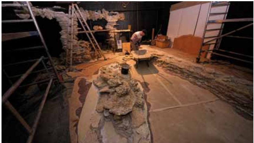
Abbildung 76. Stein auf Stein – das Korallenriff des großen Riffbeckens erhält seine Form. Es werden insge- samt ca. 20 Tonnen to- tes Riffgestein von den Fidschi-Inseln verbaut.
