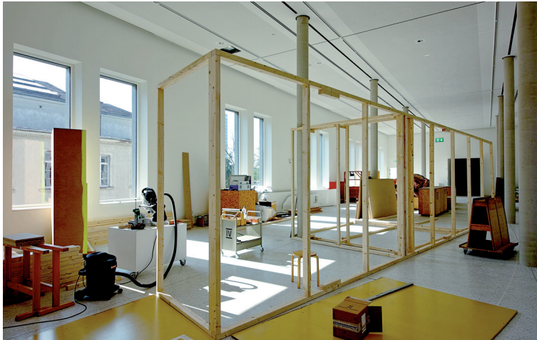
Abbildung 30. Wie ein Skelett – die Ausstellungsarchitektur nimmt Gestalt an.
